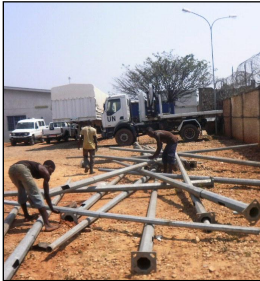
Quelques poteaux destinés à la REGIDESO
